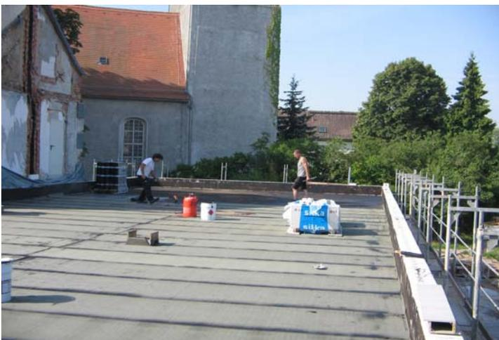
Die Dachdeckerfirma brachte am 12.07.2010 die Schweißbahnen auf, welche die Grundlage für den weiteren Aufbau des Flachdaches bieten.
